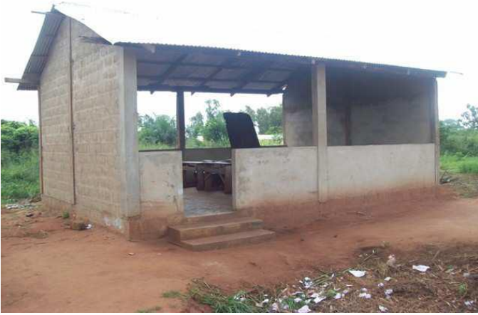
Nouvelle salle de classe construite.
